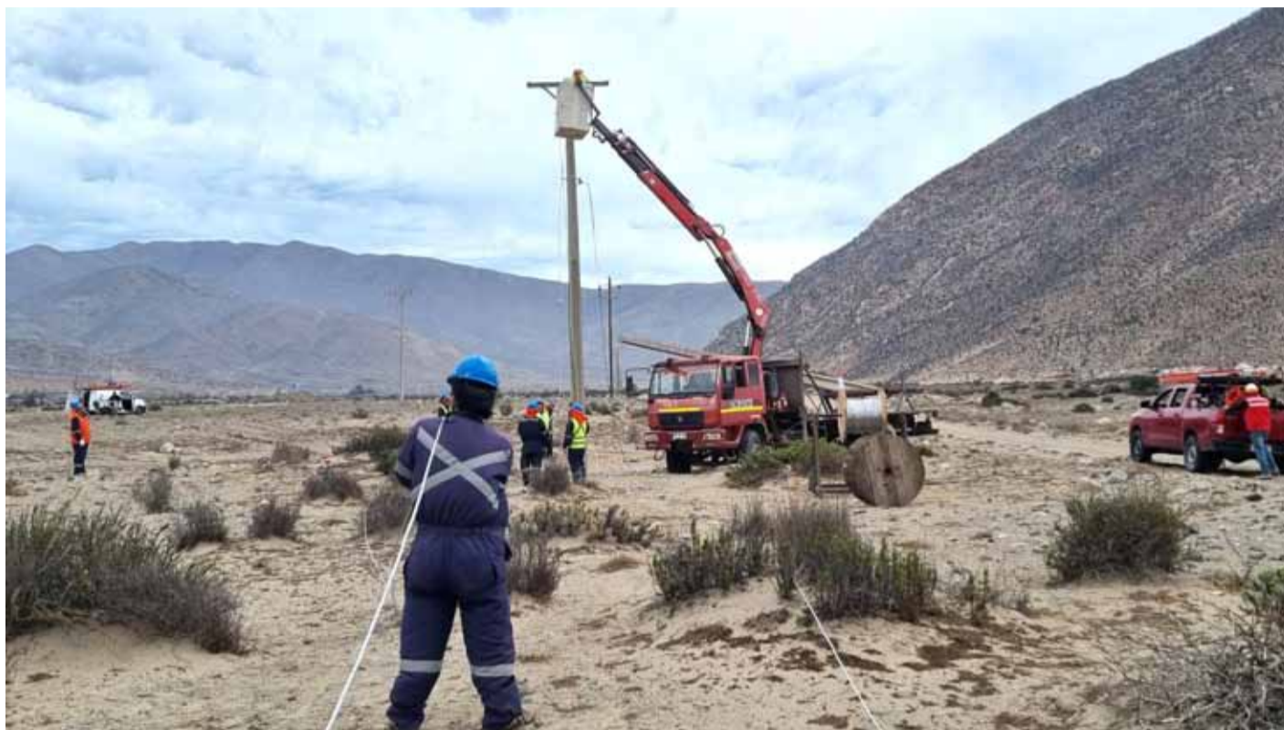
Las nuevas líneas de transmisión eléctrica que está instalando la empresa al momento de las reposiciones, están hechas de aluminio, con el fin de evitar nuevos robos de cable.
